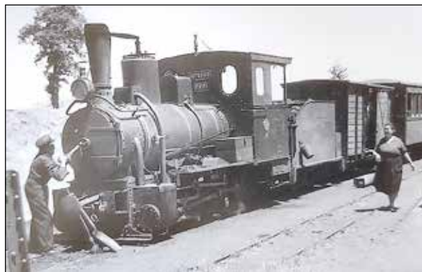
Tren de via estreta entre Valdepeñas i Puertollano
